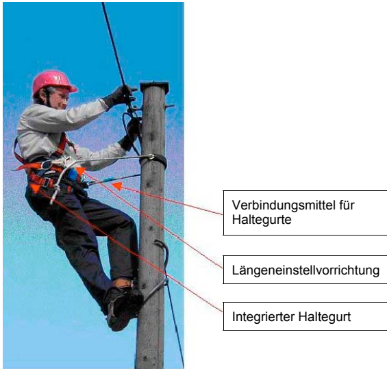
Bild 4: Arbeitsplatzpositionierung an einem Mast durch einen Auffanggurt mit integrierter Haltefunktion
